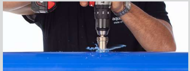
Perçement de la paroi du tube
