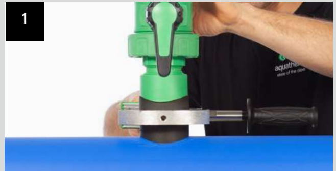
Polyfusion du kit de dérivation sur la conduite principale
