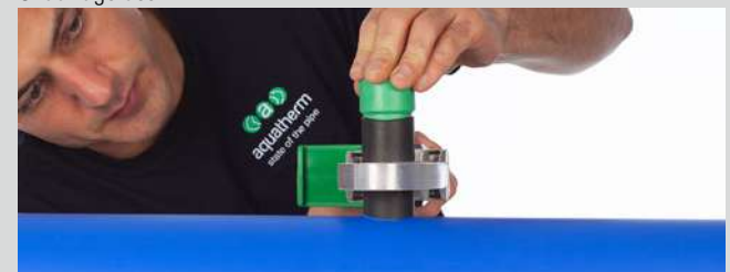
... des éléments à polyfuser.
