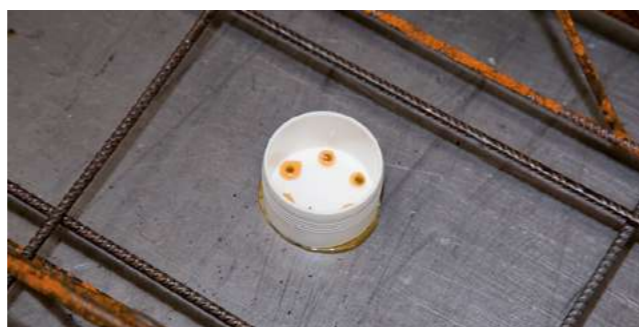
Partie inférieure de la sortie du sprinkler art. no. 3090000005 pour sprinklers encastrés. Fixation par adhésif thermofusible.
