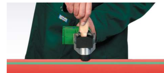
Chauffe du tube ...
