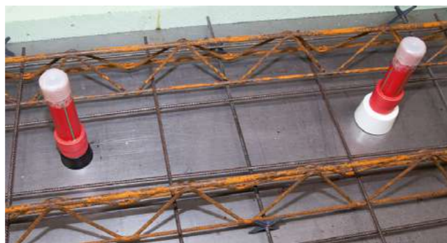
1. Type de connexion : sprinkler visible
