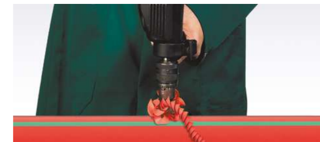
Forage à travers la paroi du tube
