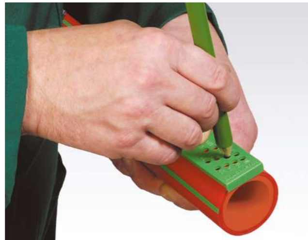
Marquage de la profondeur de soudage (selon le diamètre du tube)
