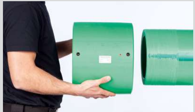
Introduire le manchon sur le tube
