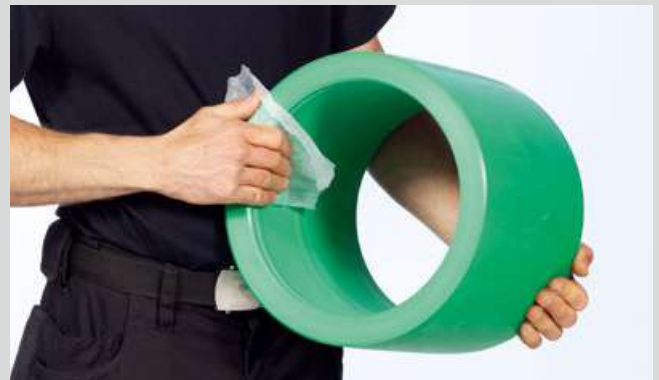
Nettoyer l'intérieur du manchon à l'aide d'un chiffon doux ou d'un papier. Contrôler et éventuellement éliminer toute trace d'humidité directement avant la soudure .
