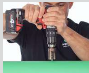
Perçement de la paroi du tube
