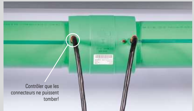
Programmer le diamètre correct au transformateur. Lancer le processus. Attendre le temps de refroidissement. Terminé!
