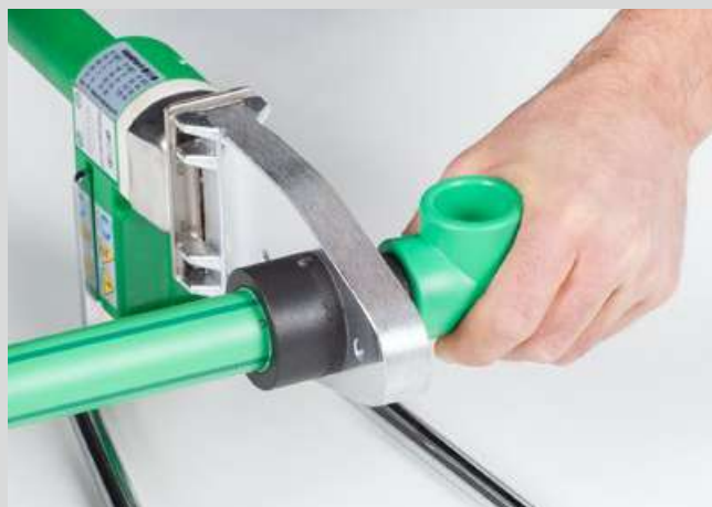
Chauffage des éléments
