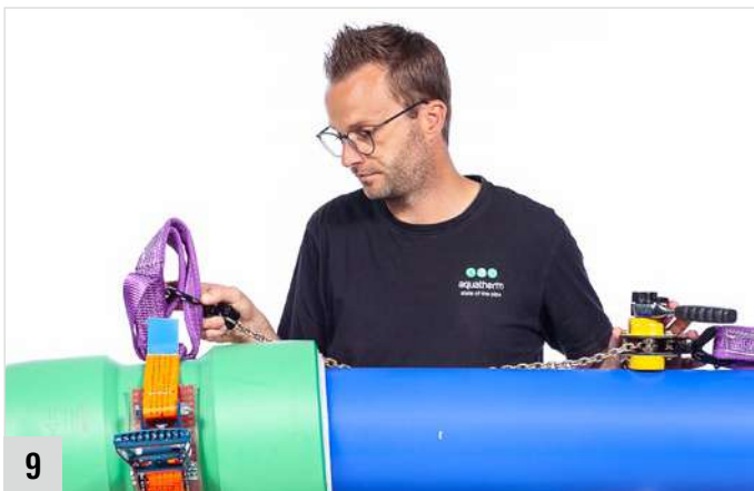
9 Fixer l'outil de traction de manière sûre sur le manchon et sur le tube.
