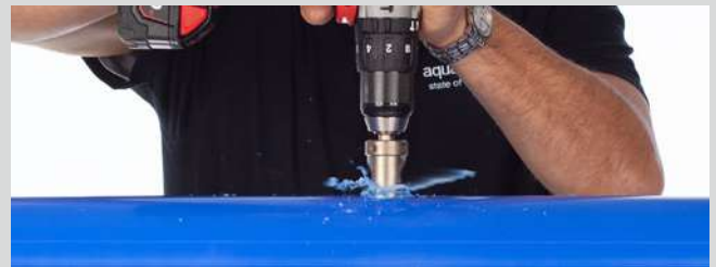
Perçement de la paroi du tube
