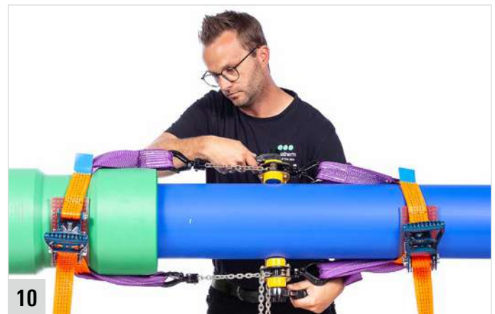
10 Emboîter de manière équilibrée le manchon coulissant sur le tube jusqu'au repère d'emboîtement préalablement tracé.
